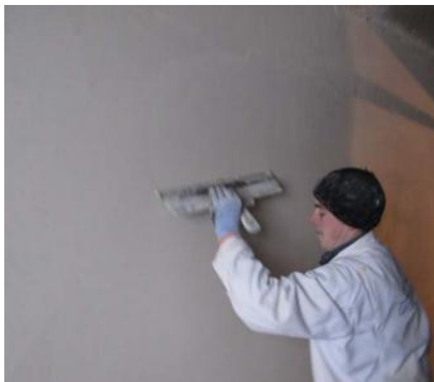
Рисунок 7 – Окончательное выравнивание поверхности шпателем
