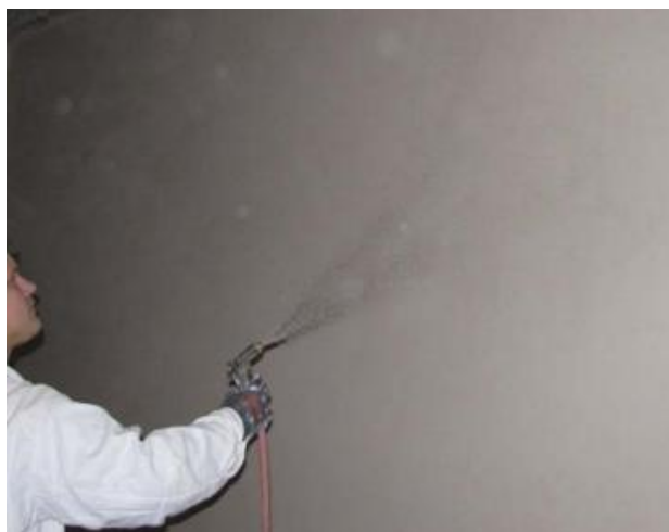
Рисунок 9 – Орошение поверхности водой
