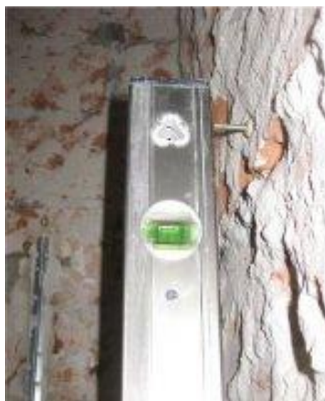
Рисунок 4 – Провешивание стен уровнем с правилом
