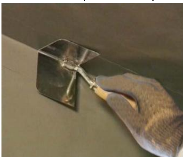
Рисунок 8 – Выравнивание внутренних углов
