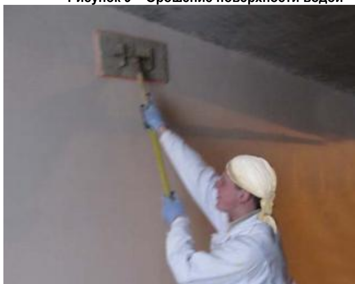
Рисунок 10 – Затирка поверхности теркой с губкой
